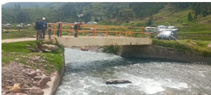
FIGURA N°02: PUENTE CARROZABLE, VIENE ESTRANGULANDO EL CAUCE DEL RIO VILCANOTA, EXPUESTOS ANTE UNA CRECIDA DEL RÍO VILCANOTA.
